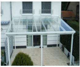
Nachdem die Vorbereitungen abgeschlossen sind, können sie mit der Eindeckung beginnen. Legen Sie die erste Stegplatte/ Glasplatte an einer Seite des Daches auf die Sparren. Diese sollte jeweils beidseitig auf dem geriffelten Bereich des Riefenauflagegummis liegen. Achten Sie darauf, das die Platte gerade auf den Gummis liegt und diese nicht verrutscht sind (das würde dann später von unten unsauber aussehen).
